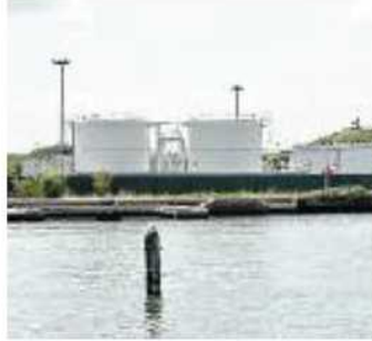
Il deposito gpl
