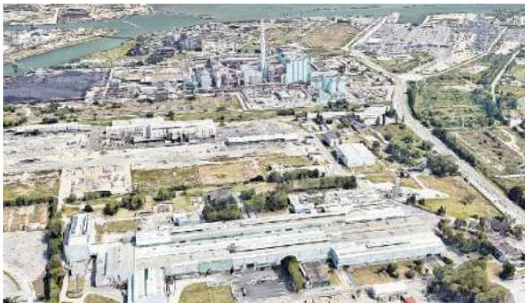
FUSINA L'area dove Veritas-Ecoprogetto realizzerà il nuovo inceneritore con, alle spalle, la centrale Enel
